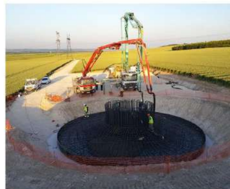
La stabilité mécanique des éoliennes face à la prise au vent est assurée par de profondes fondations en béton armé, recouvertes de terre.
